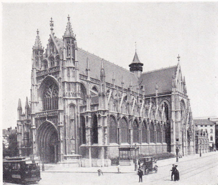
Fig. 158. — Même vue après la restauration.
